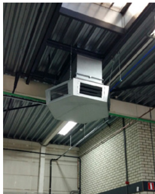
Tête de pulsion hexagonale 6 faces avec volets horizontaux
