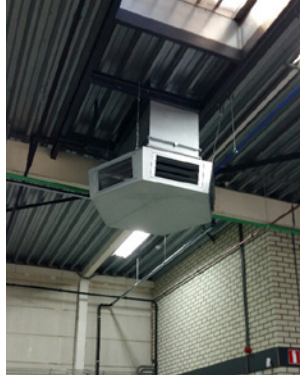
6-zijdige hexagonale uitblaaskap voorzien van horizontale schoepen
