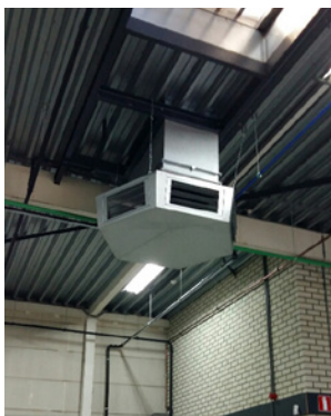
6-zijdige hexagonale uitblaaskap voorzien van horizontale schoepen
